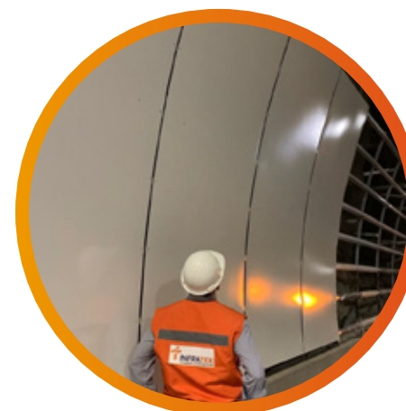
Revestimiento de Túneles
