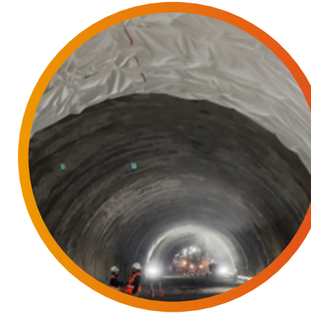
Impermeabilización de Túneles
