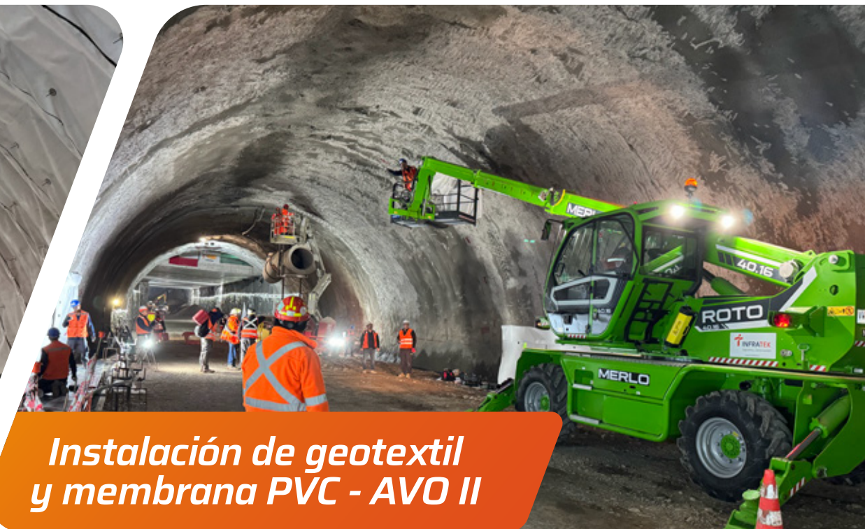
Carro para impermeabilización Túnel AVO II
